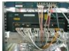
Hình 12.10. Một switch và đấu các switch với nhau thành nhiều tầng
